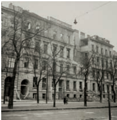
Domy na tř. Kpt. Jaroše 7 a 9 poškozené bombardováním v roce 1944.
