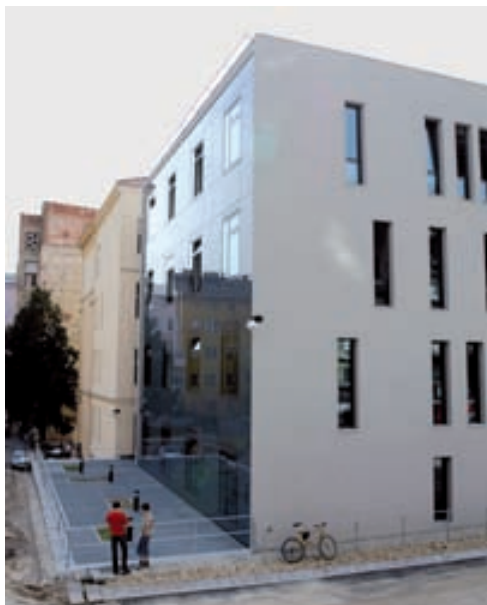
Stav těsně po dokončení.
