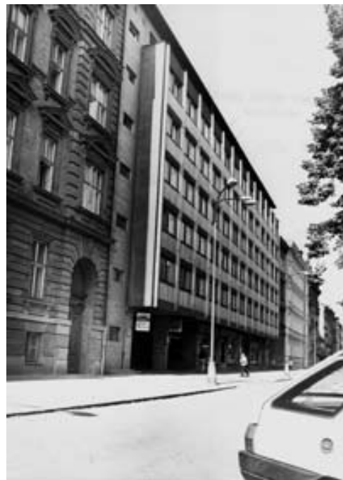
Budova na tř. Kpt. Jaroše 7 postavená koncem šedesátých let jako vojenská ubytovna.
