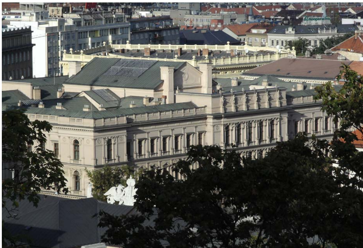
Sídlo Úřadu pro ochranu hospodářské soutěže
